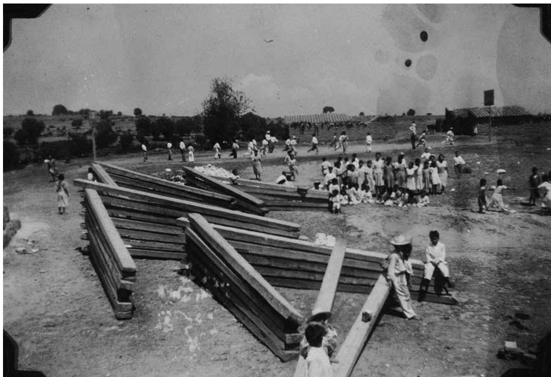
Vigas para construir la escuela de Xiloxochitla. 1946. AHSEP.
