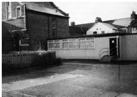
Figura 2. El aula prefabricada ocupa el patio (Armitage, 2005)
