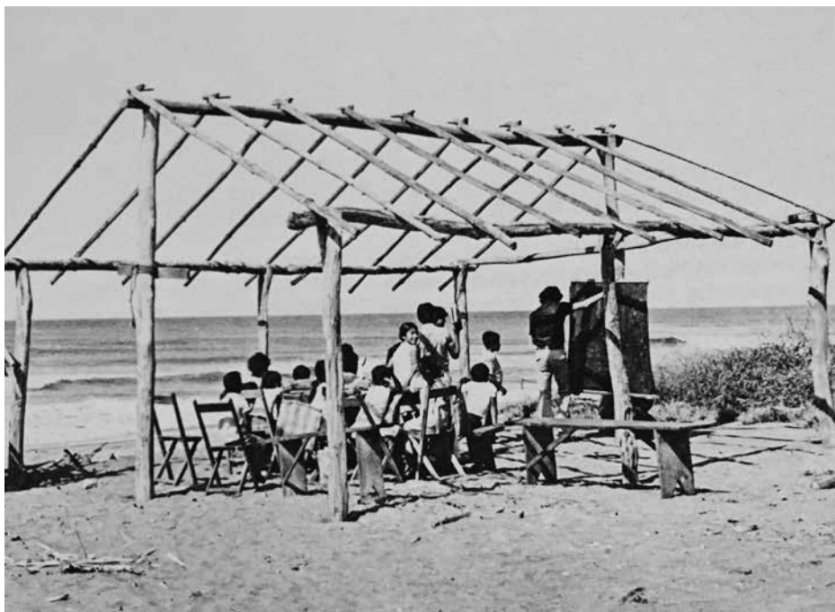
Escuela rural unidocente en construcción, 1970's. Foto de Carlos Blanco.
